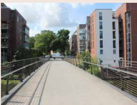
Ein Brückenschlag nach Barmbek-Süd
