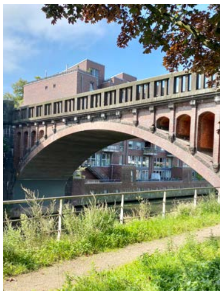
Alte Bahnbrücke über die Osterbek
