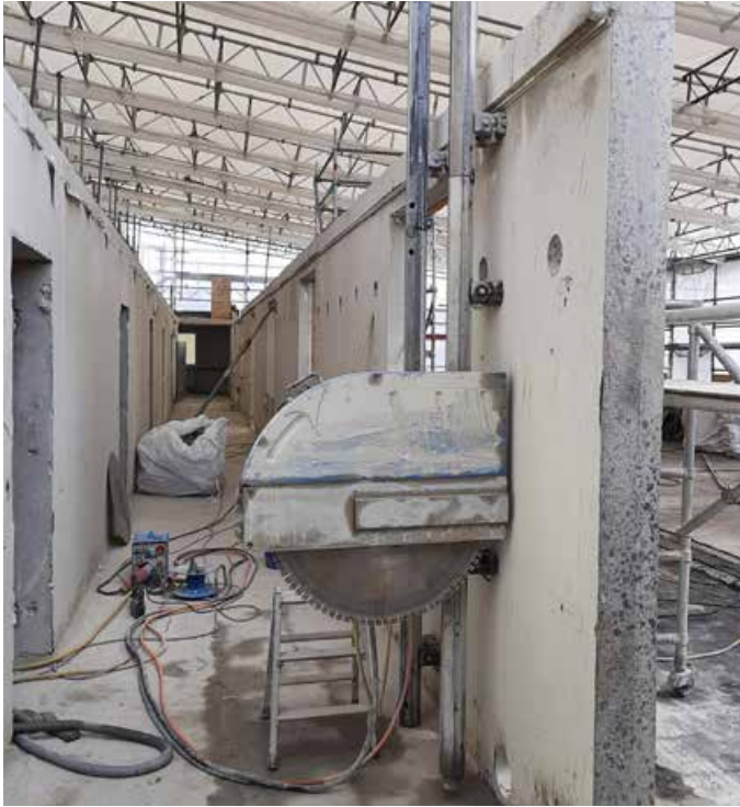
Eine Baustelle, die es in sich hatte: Umbau im 6. OG Foto: KS
