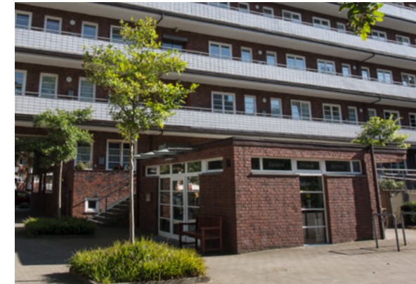
Umbau der ehemaligen Ladengeschäfte
